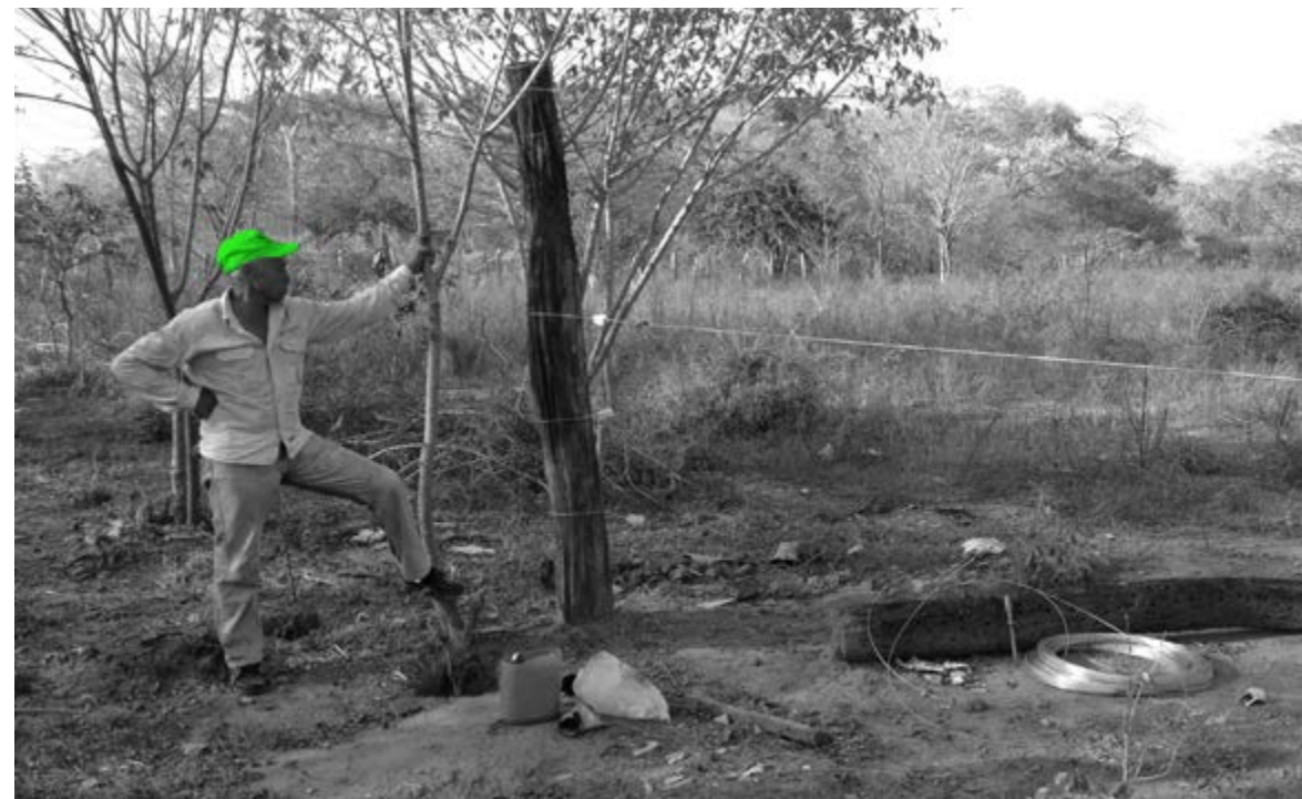
Foto 27. Instalación de cerca eléctrica en árboles de cerca viva, Casacara (Cesar)
